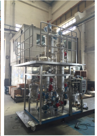
中试实验系统 Pilot test system
